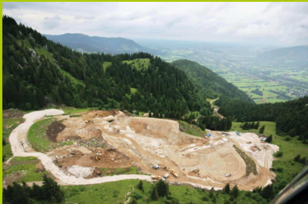
In schneeunsicheren Skigebieten ist der Wunsch nach Kunstschnee groß, weshalb immer mehr künstlich angelegte Speicherseen wie dieser am Brauneck gebaut werden.
