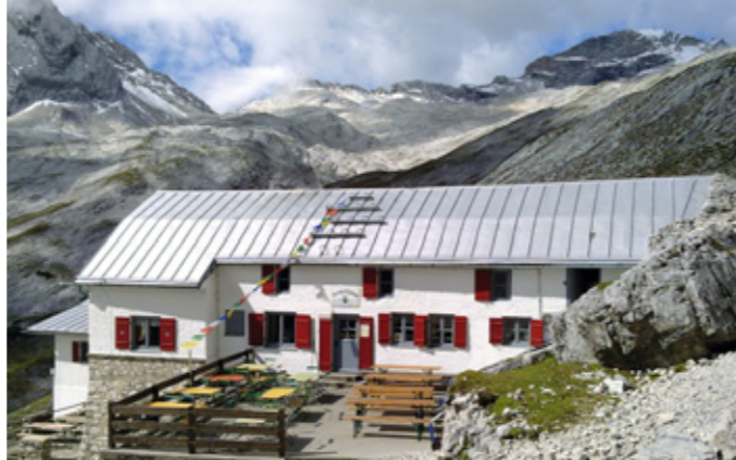
Die Knorrhütte, erbaut 1855, ist eine der ältesten Alpenvereinshöhlen
