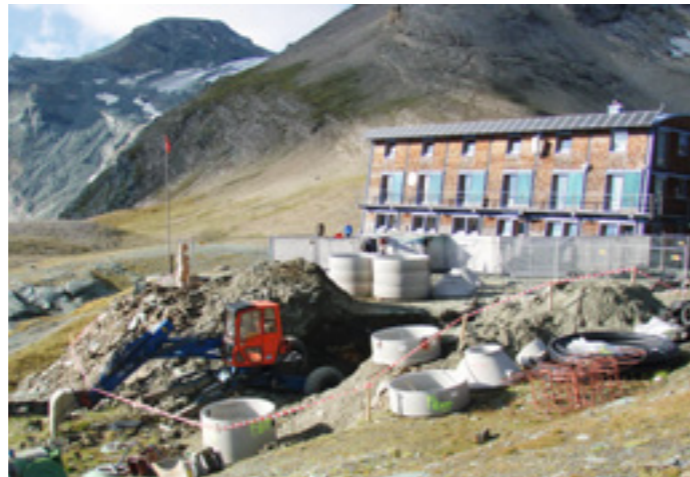
Das Umfeld der Stüdlhütte war zeitweilig eine Großbaustelle
